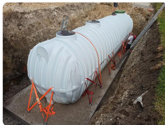
Ancoragem do reservatório RoDrive com cintas de poliéster.
